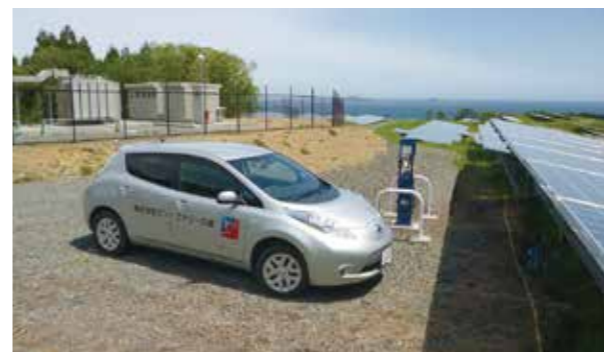
発電サイト(メンテナンス用電気自動車)
