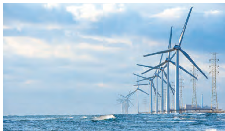
茨城県 | 2011年竣工
