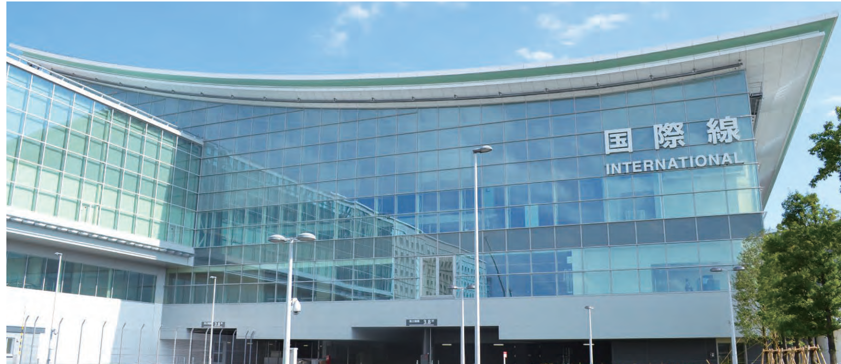
東京都 | 2014年増築・竣工
